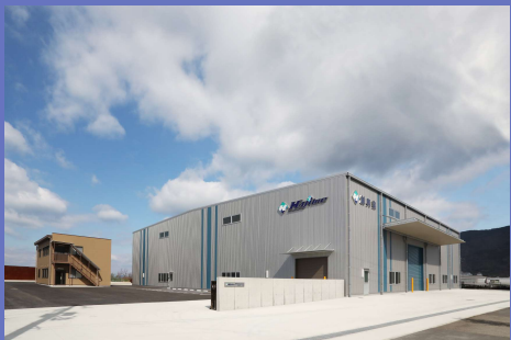
令和2年新設 林田第二工場
