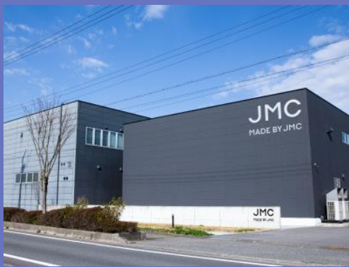
コンセプトセンター ( casting工場:長野県飯田市)
