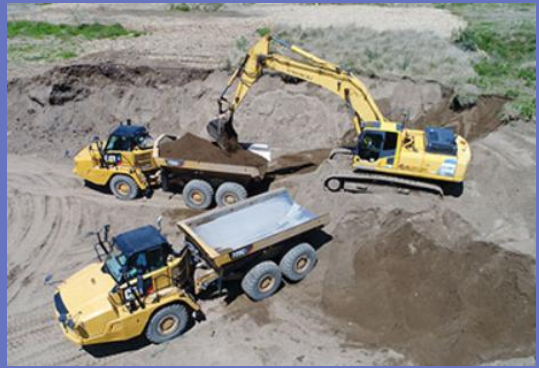
臨海工業用地等造成工事
