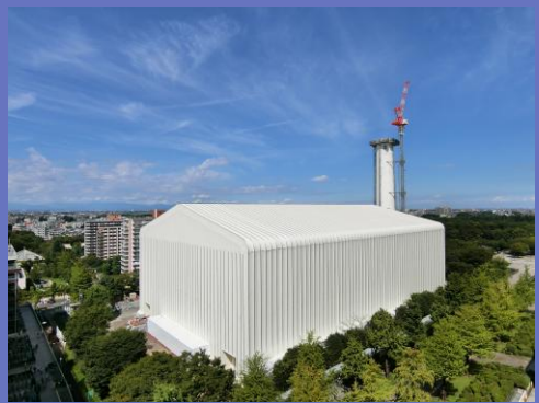
東京練馬区光が丘清掃工場建替工事
