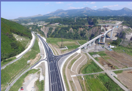
工事写真 (熊本地震で崩落した阿蘇大橋へ 続く道路の復旧工事)
