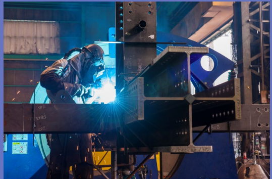
鉄骨溶接の様子
