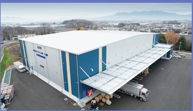
伊勢崎インター倉庫
