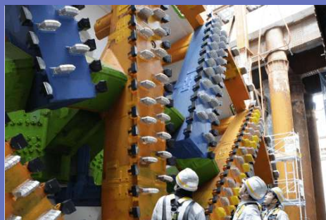
シールドトンネル掘削機カッター面
