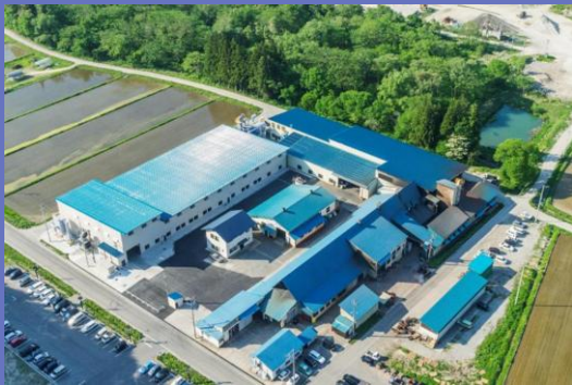
株式会社会津工場 本社工場全景
