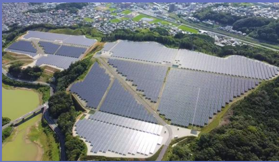
福岡県宗像市 太陽光発電所
