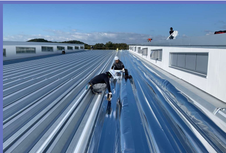
遮熱シート「サーモバリア」 スカイ工法施工事例
