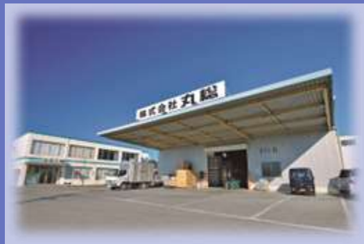
本社事務所及び本社倉庫
