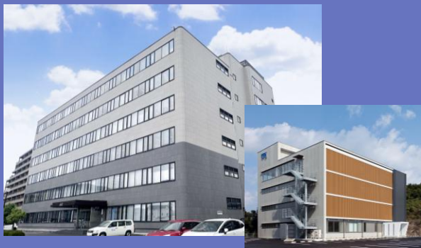
本社(タイムプラザビル)／CTPビル
