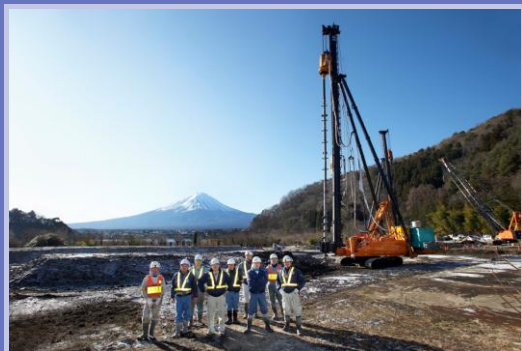
杭の販売と基礎施工で地震対策
