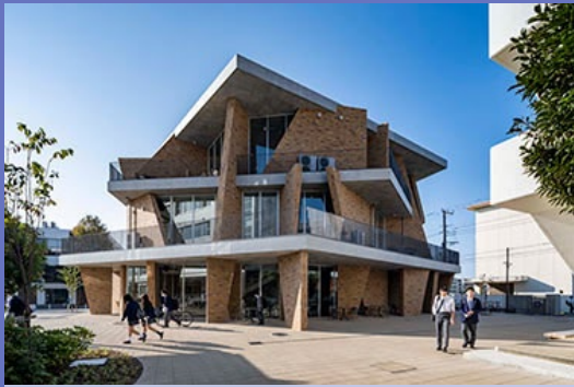
湘南工科大学SIT新図書館 （新築工事）
