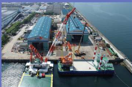
SKK多度津工場と海上クレーン
