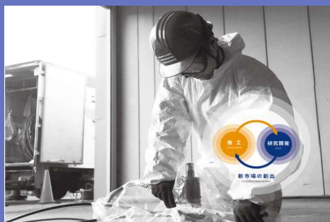
ウレタン注入状況
