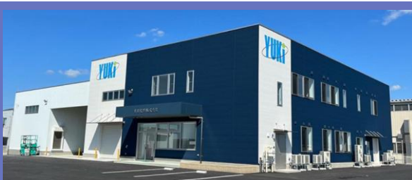
本社工場の外観
