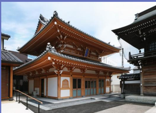
施工実績（社寺仏閣）
