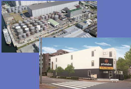
丸善京葉油槽所とトランクルーム
