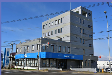
SUMi TAS直営店舗・リフォーム施工事例（写真）
