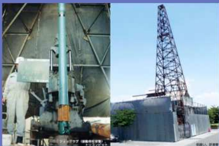
温泉掘削工事
