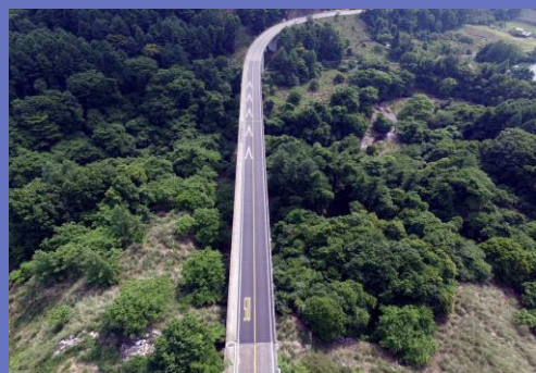
橋梁補修工事現場
