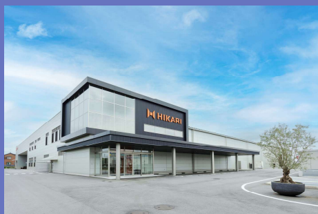
本社・西尾工場外観
