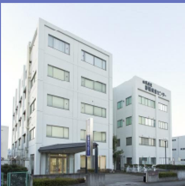
本社環境衛生研究所
