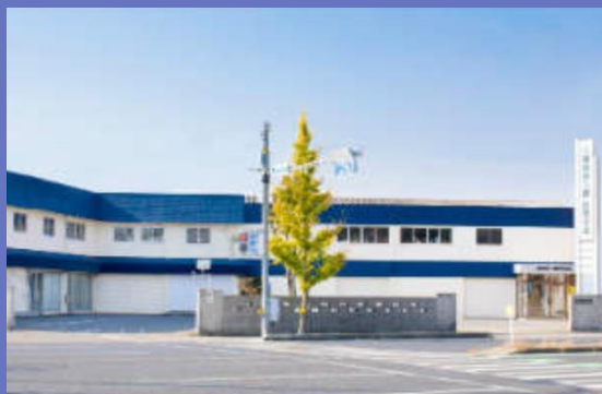
三要電熱工業(株)本社事務所
