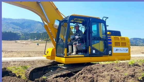
施工現場の様子
