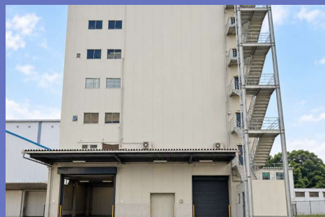
臨海町配送センター（江戸川区）
