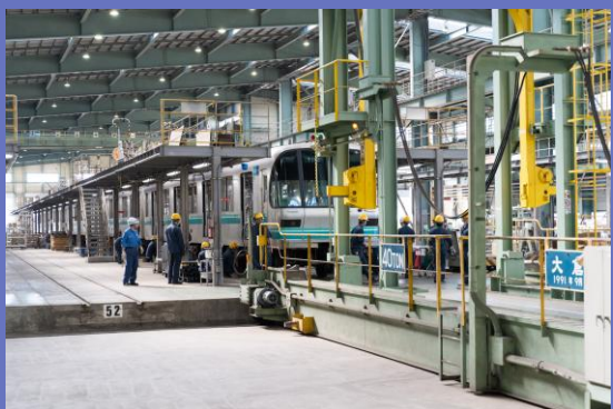
鉄道車両の改造工事の様子
