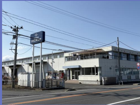
（株）サカ工鉄工所 本社外観
