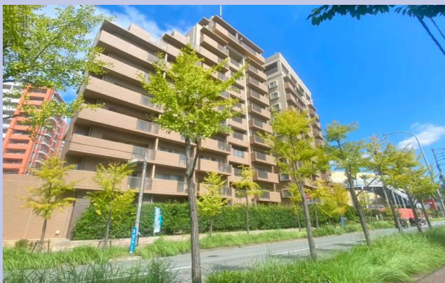
大規模修繕工事（福岡県W複合施設）
