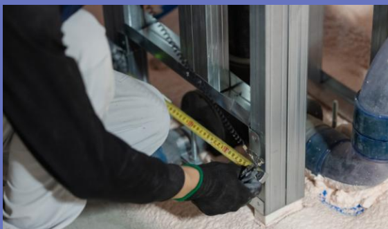
LGS（軽量鉄骨下地）工事
