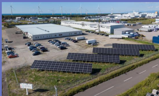
ロジスティクスセンター
