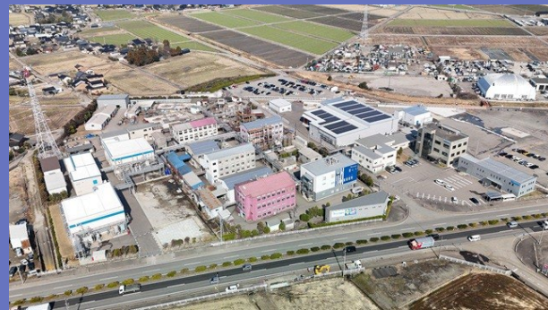
本社事務所・工場・研究棟
