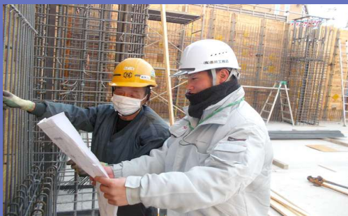
当社の強みの躯体工事
