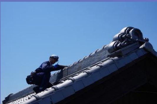
瓦屋根 葺き替え工事
