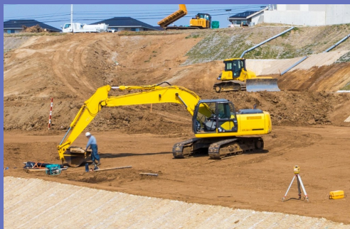
土木工事現場
