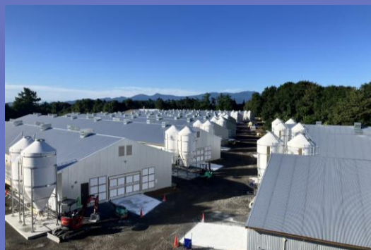
大型木造施設・畜産施設施工
