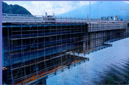
当社が手掛ける橋梁補修工事
