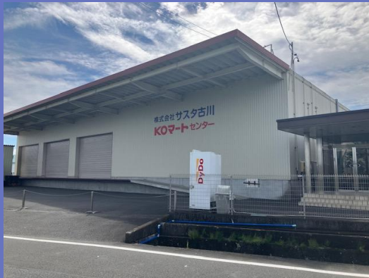
(株)サスタ古川本社倉庫
