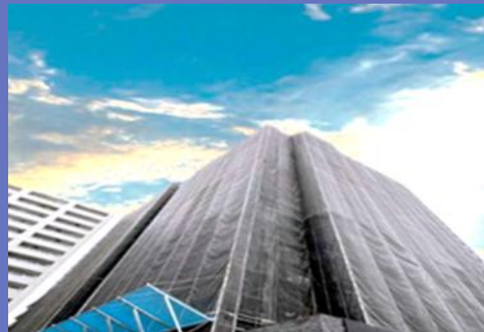
当社施工：高層マンション大規模修繕工事
